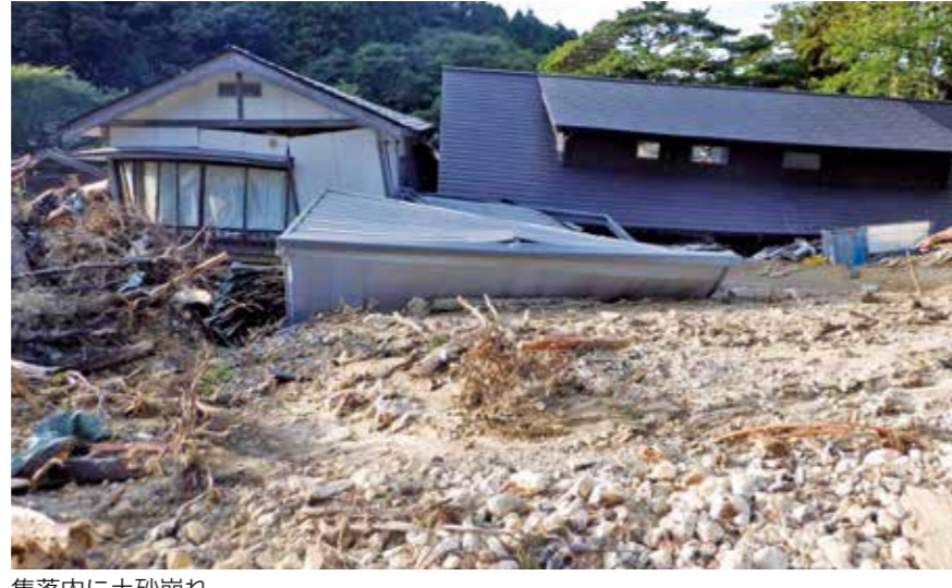
集落内に土砂崩れ
