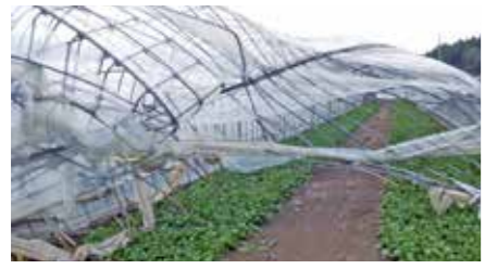
変形したハウス
