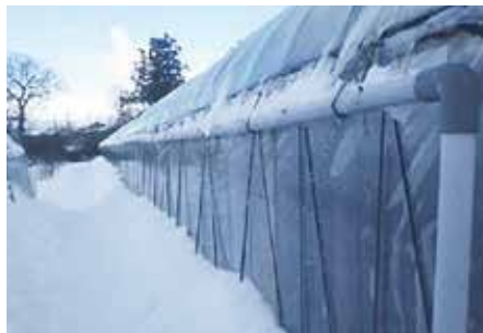
融雪パイプの設置
